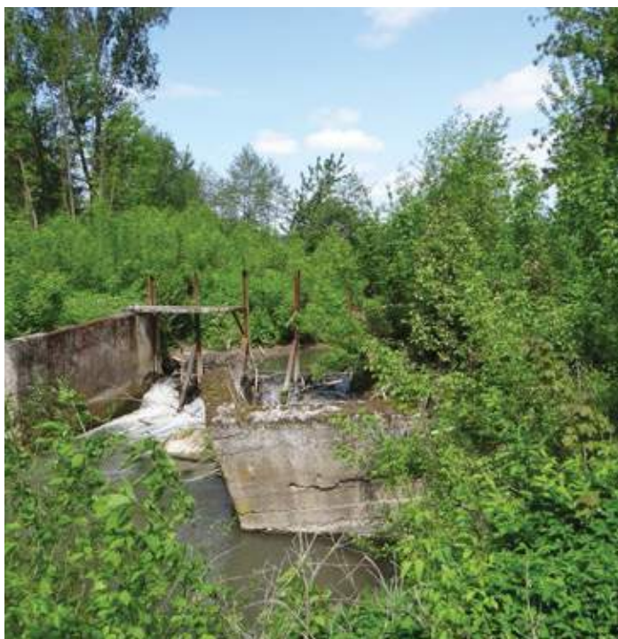
Fot. 1 Zły stan jazu kwalifikował go wyłącznie do gruntownej odbudowy
