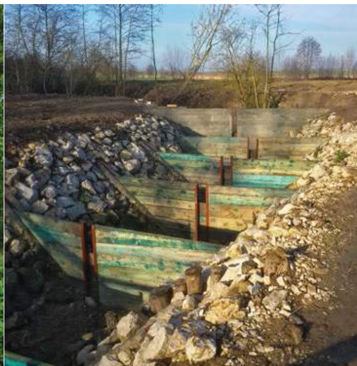
Fot. 2 Przepławka podczas budowy MEW pełniła rolę kanału obiegowego
